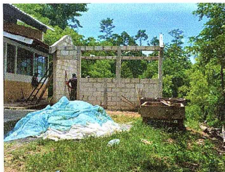
Foto1: REPARACION DE COCINA
