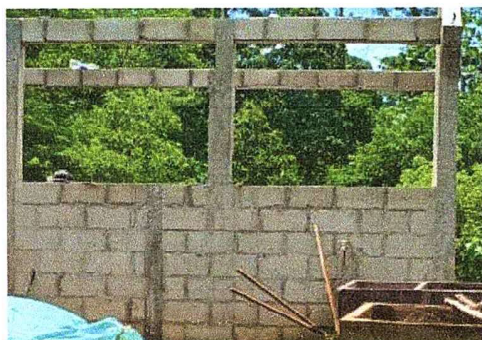
Foto 3: SUSTITUCION DE VENTANA DE COCINA
