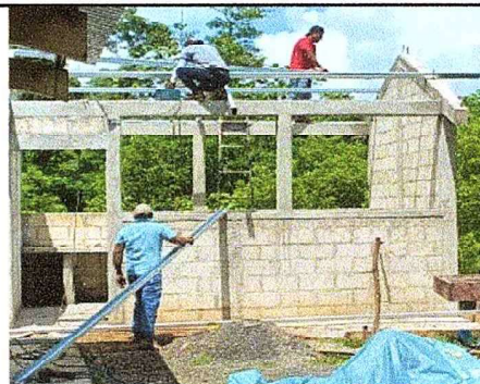
Foto 2: ENTECHADO DE COCINA
