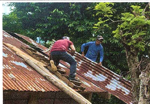
Foto 4: SUSTITUCION DE TECHO DEL ESTABLECIMIENTO
